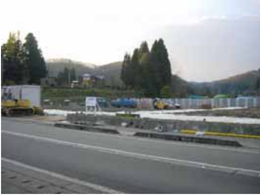
塚山小近くの仮設住宅建設現場
