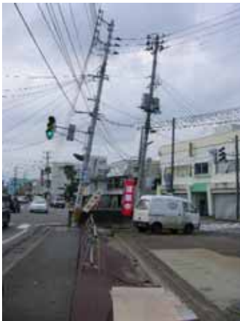
中沢三叉路 液状化で歩道が 陥没、電柱も傾斜
