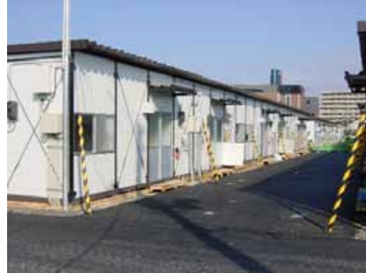
同左・住宅の様子。完成し入居を待つ状態
