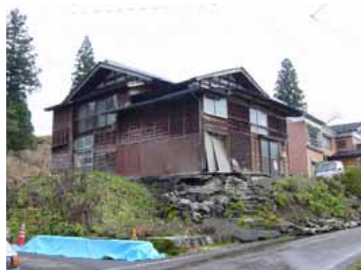
被害のみられる古い木造家屋
