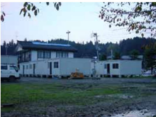
朝日公民館裏の仮設住宅建設現場
