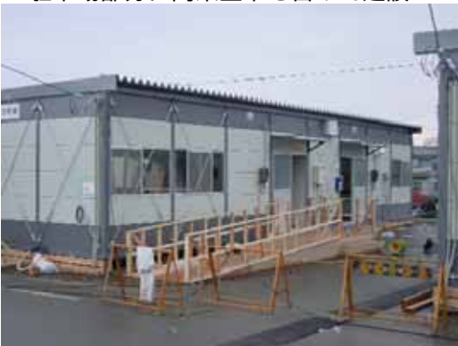
談話室にはスロープが設置されている
