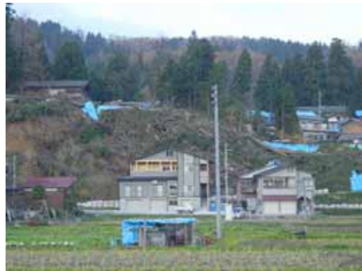
同左の箇所。反対方向からの様子
