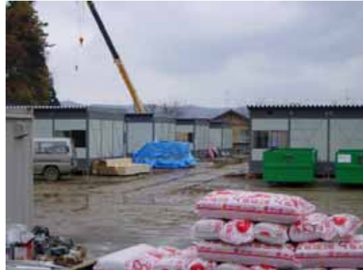
工事中の状況
