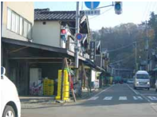
古い建物で若干傾斜がみられ、応急的に補修
