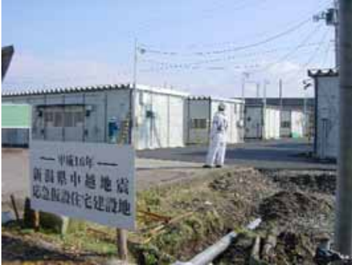
操車場北側の仮設住宅地入口
