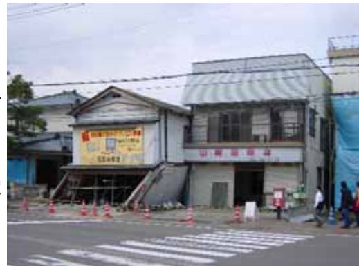
中沢三叉路 液状化で歩道が 陥没、電柱も傾斜
