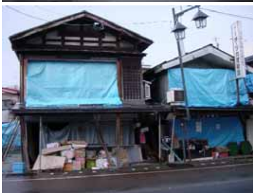
古い木造建物を中心に被害が大きい
