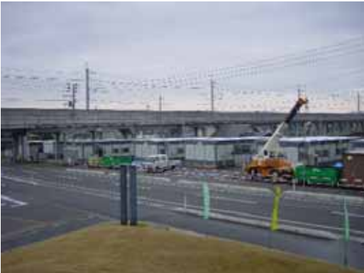
駐車場部分に高架直下も含めて建設
