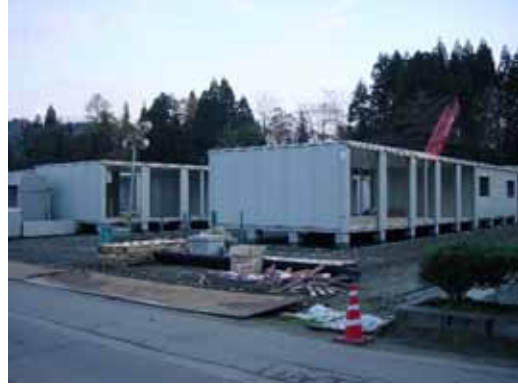
西谷集会場裏の仮設住宅建設現場
