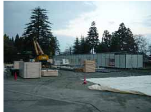
郷土資料館脇の仮設住宅建設現場
