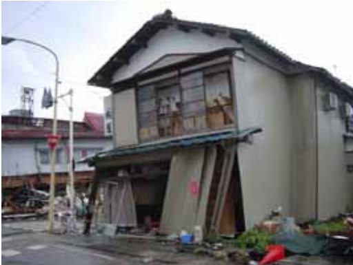
駅前の被害建物。左奥の店舗は1階が潰れる。
