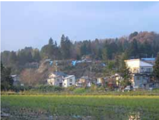
西谷地区。斜面が崩れ上部の住宅にも被害
