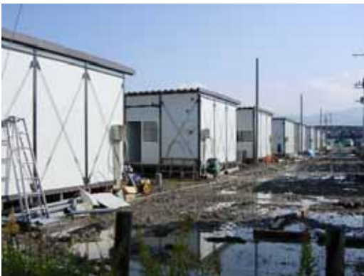
操車場南側の様子。建設中
