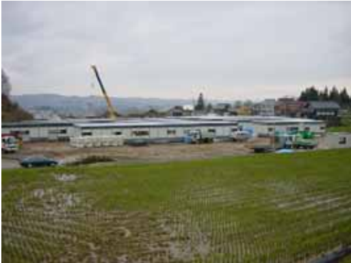
住宅地全景。山沿いの高台に位置する
