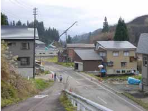
集落の南側に建設されている仮設住宅
