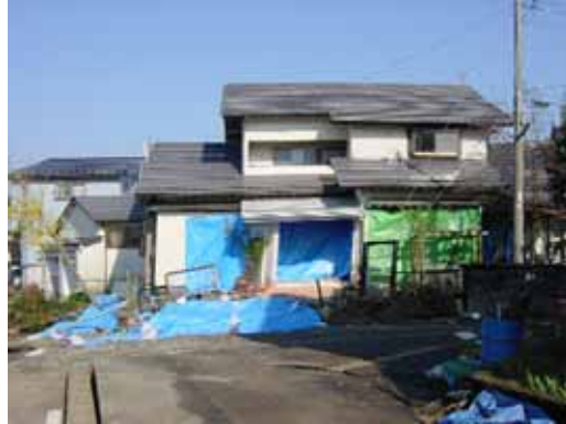
地盤が崩れたために傾いた住宅
