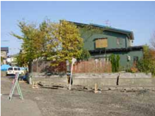
団地北東側。道路の斜面が崩れ宅地に被害
